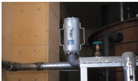
分支安装范例(单侧封闭法兰可分支安装)
